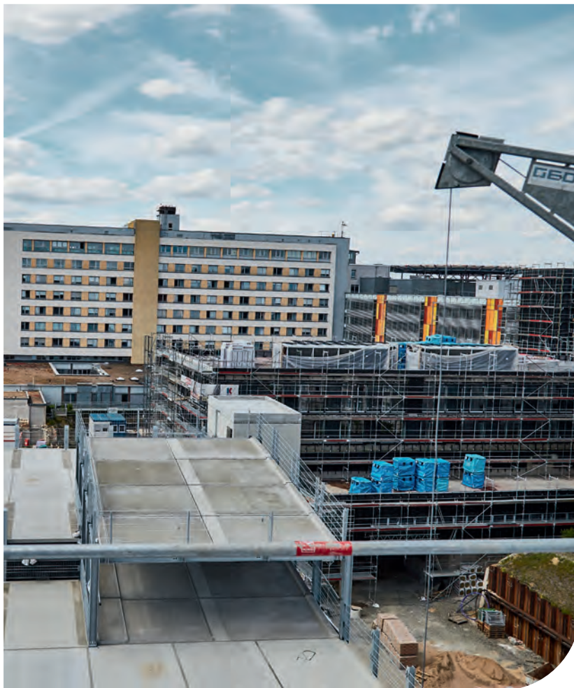
Die Großbaustelle am Klinikstandort Detmold liegt im Zeitplan. Die ersten Bereiche werden wohl wie geplant im April 2023 eingeweiht.
