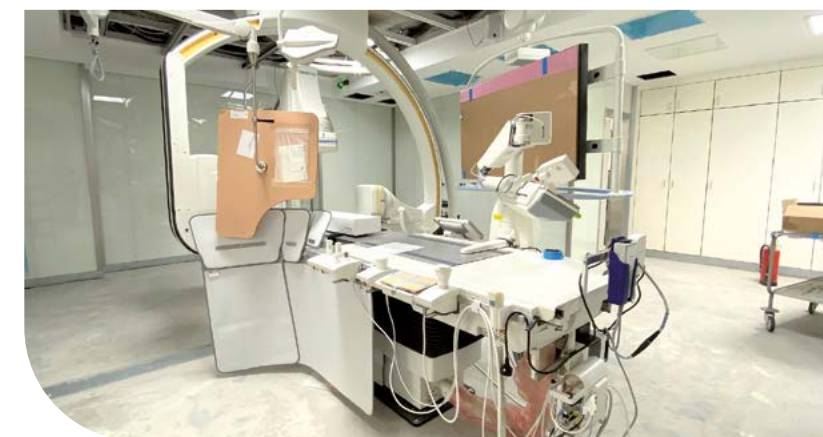
Die Installation und Inbetriebnahme der Großgeräte am Klinikum Lippe erfordert viel Engagement und Teamwork. Auf dem Bild zu sehen: Baustelle Corindus in der Universitätsklinik für Kardiologie im Februar 2022.
